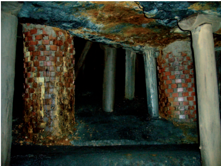
Abbildung 3: Neben den Holzstempeln wurden Trockenpfeiler zur Vermeidung von Firstverbrüchen gesetzt.
