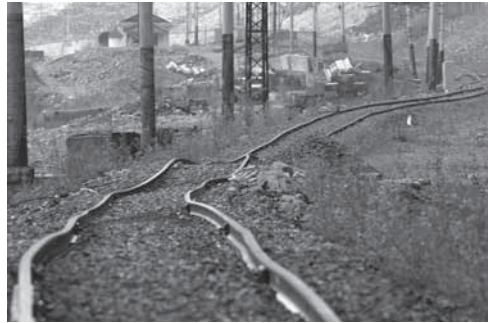
Abbildung 2b (oben): Senkungen und Verwerfungen von Bahngleiskörpern durch auftauenden Permafrost. Quelle: Future World Project 2011
