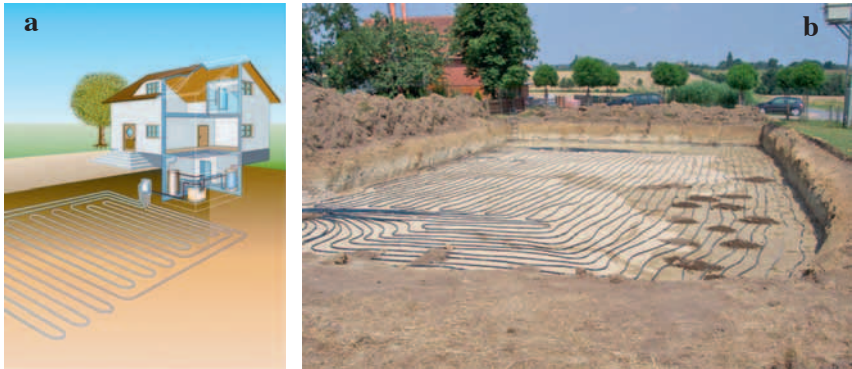
Abbildung 16: a) Prinzipdarstellung einer flüssigkeitsdurchströmten Erdwärmekollektor-Anlage mit b) einer Ansicht während der Verlegung der Rohre in der offenen Baugrube
