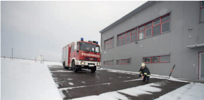
Abbildung 11: Geothermisches Wärmerohrkonzept für die selbsttätige Schnee- und Eisfreihaltung der Feuerwehrrampe in Bad Waldsee, oben Schema, unten auf dem Foto dokumentierter Erfolg, aus [19]
