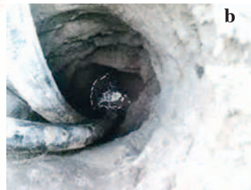
Abbildung 15: a) Prinzipdarstellung einer Anlage mit flüssigkeitsdurchströmter Erdwärmesonde mit b) U-Rohren aus Kunststoff
