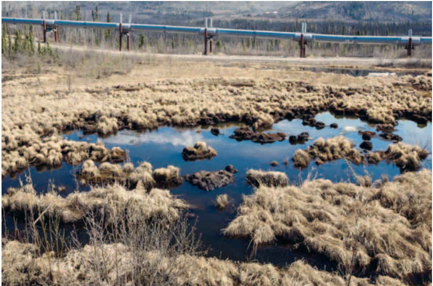
Abbildung 4a: Trans-Alaska-Pipeline in aufgetautem Gelände, aus [4]
