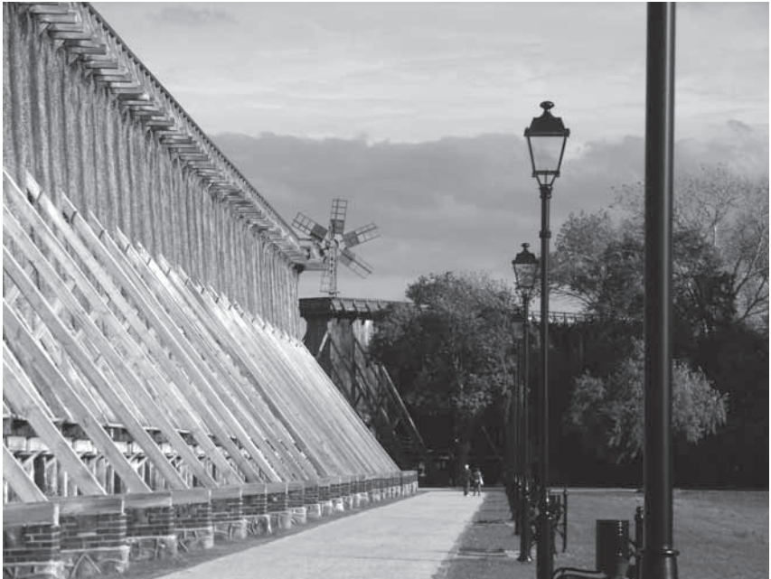
Abb. 8: Ausschnitt aus dem Slonsker Gradierwerk in Ciechocinek mit Umsteuervorrichtung (Windrad) für den Berieselungsmechanismus
