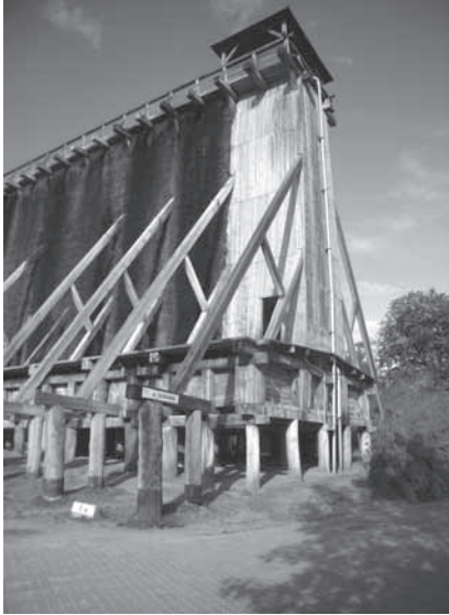
Abb. 1: Schmalseite eines der drei Gradierhäuser in Słoińsk an der Wisła
