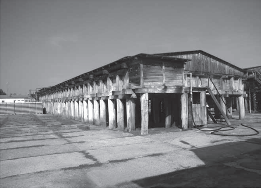
Bild 9: Auf Piloten aufgesetztes Solereservoir in Slonsk
