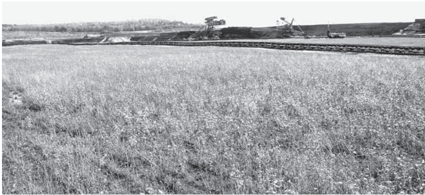
Abb. 7: Erste Rekultivierungsschritte direkt neben dem Abbau der Braunkohle. Nach der Flächenbegrüdnung erfolgt eine erste Ansaat anspruchsloser Pflanzen, die die Staubbildung vermindern und eine erste Bodenfestigung bewirken sollen. Die Bodenbearbeitung mit schwerem Gerät muss vermieden werden, da zusätzliche Bodenverdichtungen auftreten können. Quelle: Eigene Aufnahme
