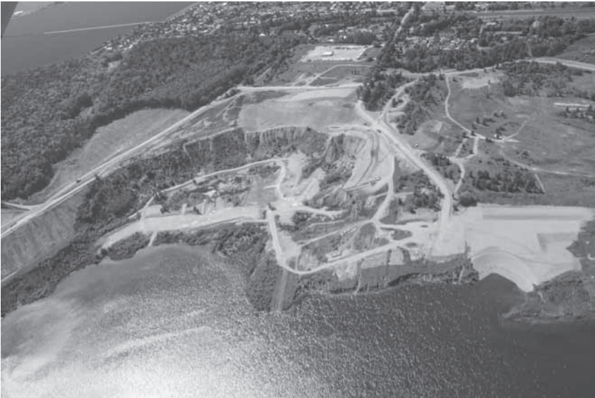
Abb. 7: Rutschungskessel vom 18.07.2009 in Nachterstedt (Situation 2015) (Quelle: Andreas Berkner)
