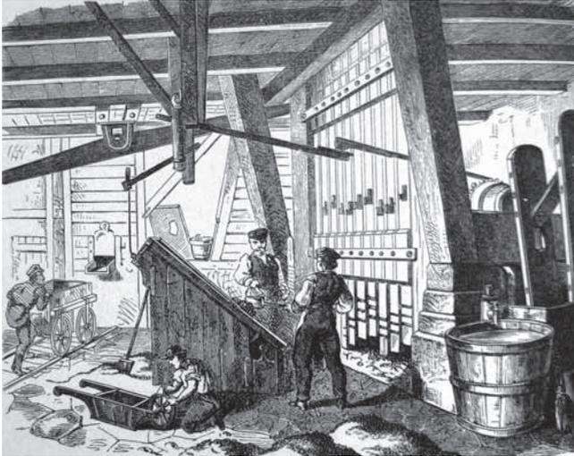
**Abb. 14:** Pochwerk um 1800. Erzklumpen wurden von in Reihe angeordneten Fallhämmern zerschlagen. Diese wurden über Gestänge von der Welle eines Wasserrades angetrieben [Berdrow 1901, S. 263].
