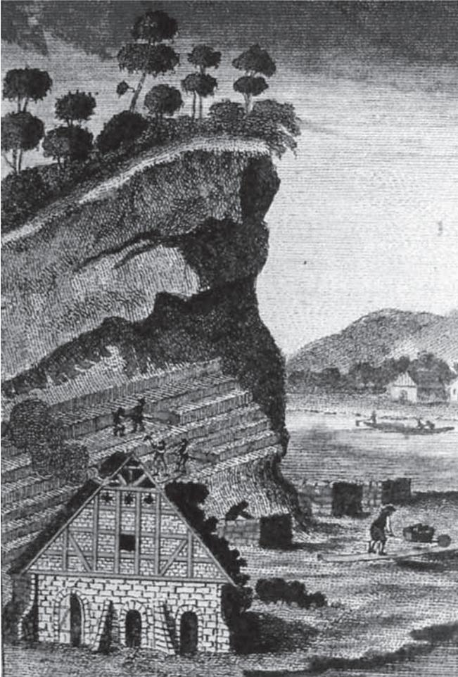
*Abb. 4: Die Rüdersdorfer Kalksteinbrüche um 1795. Im Original kolorierter Stich aus der Neuen Bildergalerie für junge Söhne und Töchter. Bd. 2, Berlin, Tafel IV [Anonym 1795b]. Zu erkennen sind außer dem hoch aufragenden Kalkfelsen der Abbau in Terrassen, die zum Abtransport auf Kähnen vorbereiteten Kalksteinblöcke und im Vordergrund unten links das Gebäude mit den Brennöfen zur Branntkalkgewinnung*
