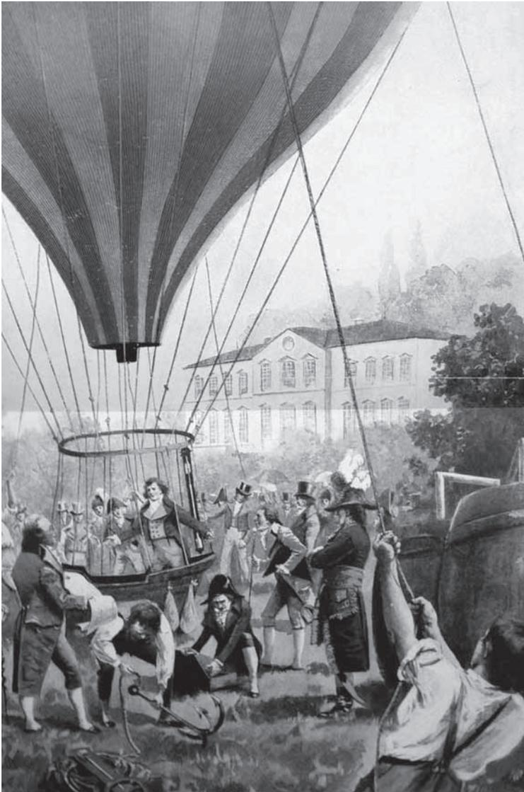
**Abb. 7: Forschungsflug von Gay-Lussac und Biot (Paris 1805). Auf der rechten Bildseite erkennt man die etwa mannshohen Holzfässer der Wasserstoff-Generatoren. Zeitgenössische farbige Zeichnung**
