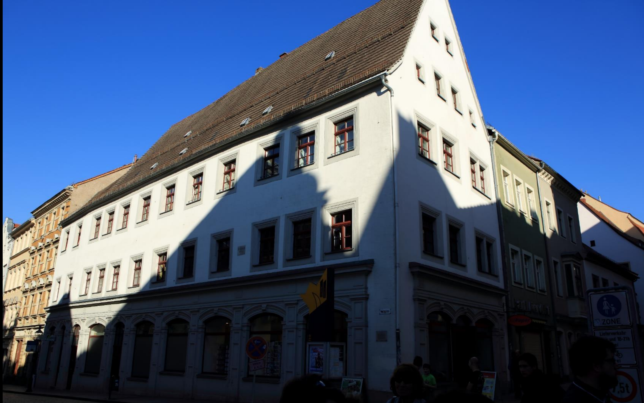
Zeitweiliges Wohnhaus Alexander von Humboldts, Freiberg, Weingasse 2 (2016)
