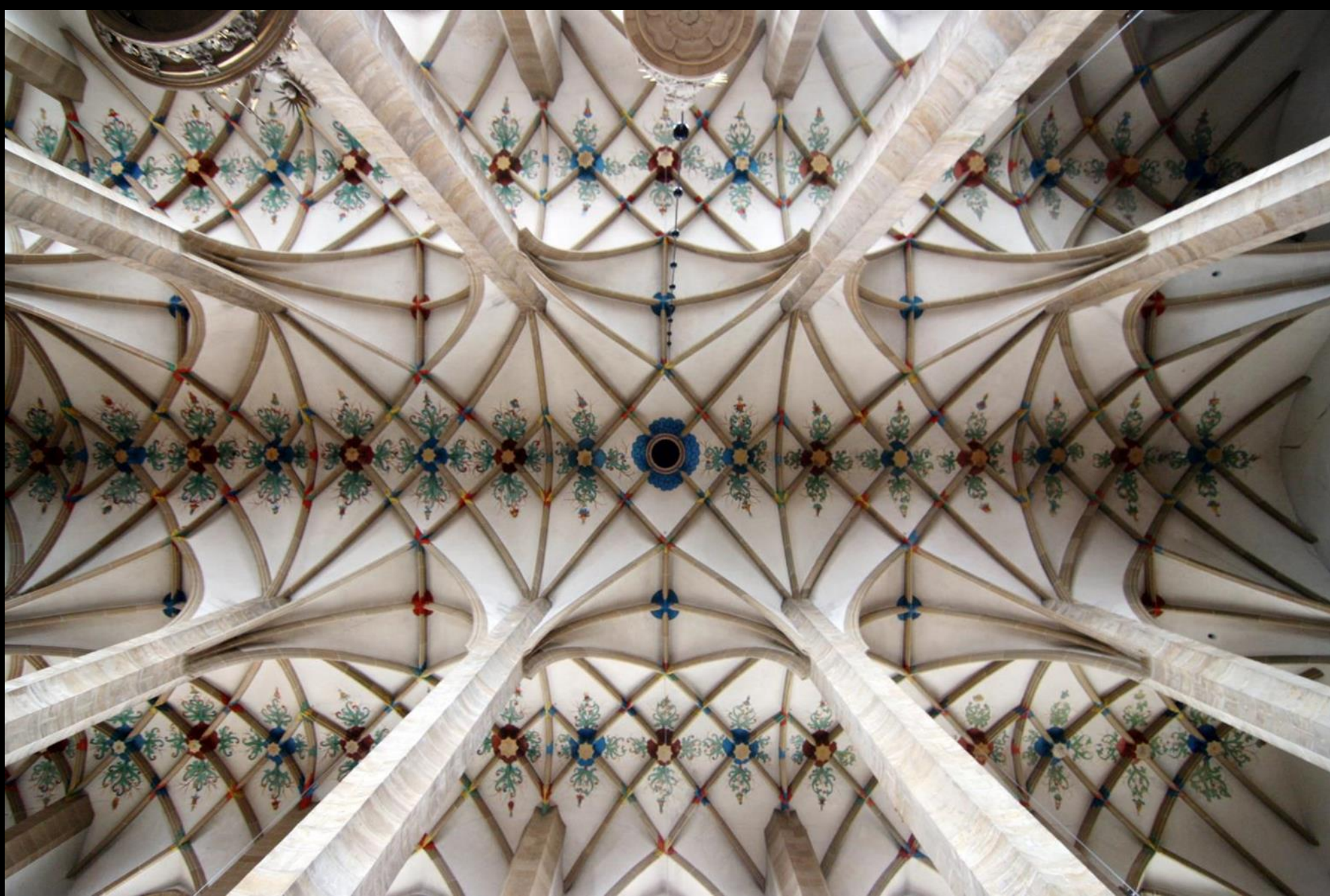
Netzgewölbe im Langhaus
