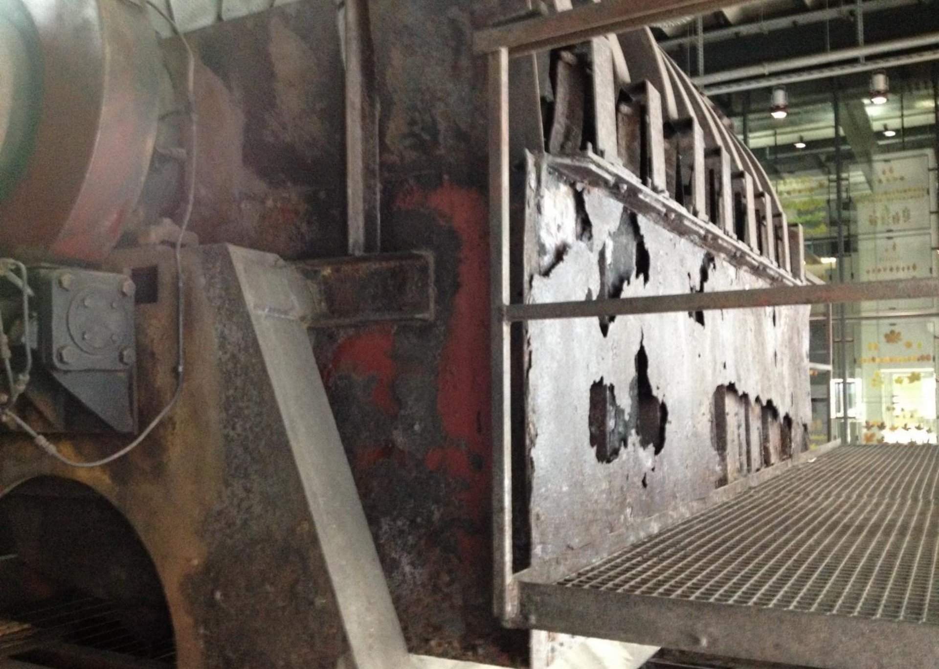
Eine alte Maschine der ehemaligen Kohlenwäsche
