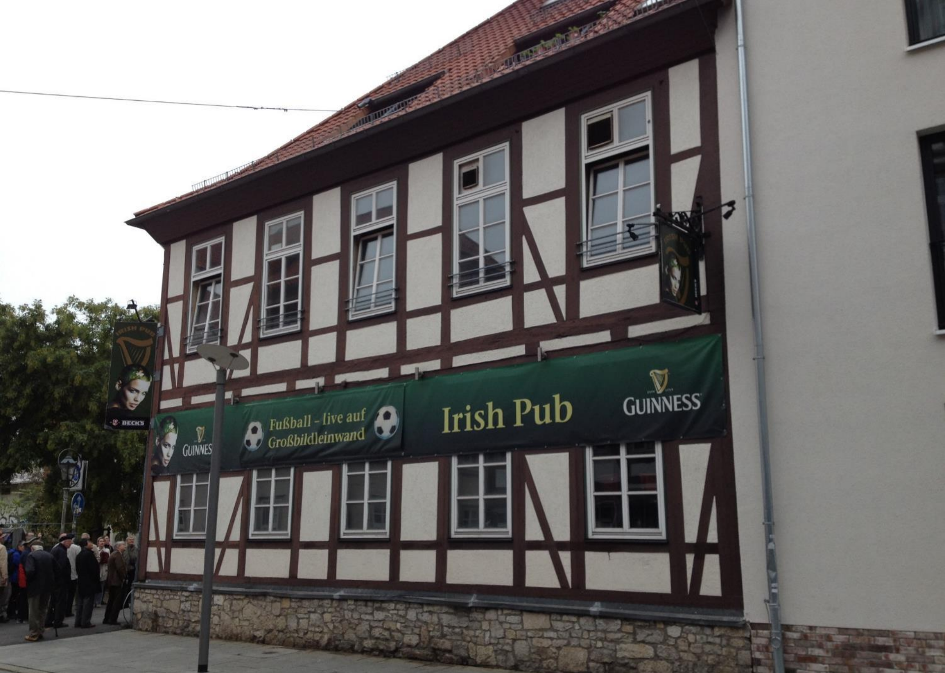
Mühlenstr. 4: deutlich bescheidener die Wohnung der Humboldt-Brüder im SS 1789
