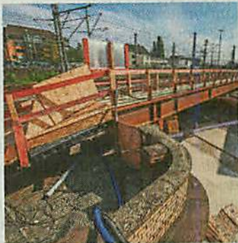
Alles klar zum Abriss: Die Eisenbahnbrücke Königstraße von 1880.
